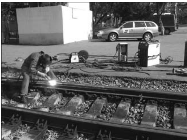
Наплавка рельсовых окончаний порошковой проволокой ОК Tubrodur 15.43
