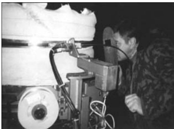
Рис. 2. Общий вид аппарата «Autotig 600РС» французской фирмы «Polysoude», предназначенного для сварки контрольного кольцевого стыка
