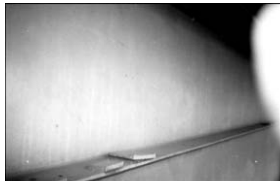
Рис. 4. Приварка фланговыми угловыми швами временных сборочных приспособлений к продольным ребрам главных балок моста им. Е. О. Патона
