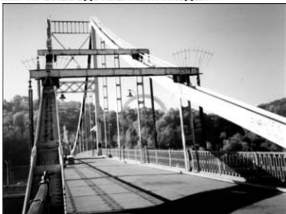
Рис. 5. Парковый пешеходный мост на Труханов остров с устройствами для разгрузки подвесок
