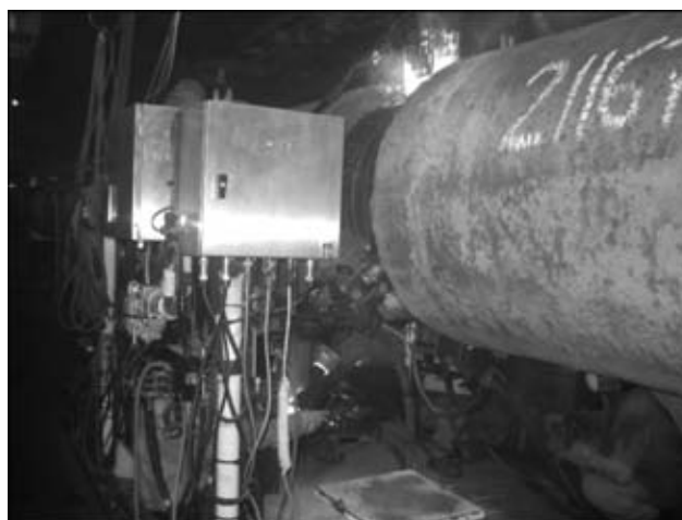
Сварочная система TransPuls Synergic 3200 Pipe для одновременного нанесения двух перекрывающих слоев в одном соединении
