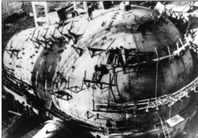
Рис. 4. Общий вид монтажа воздухонагревателя
