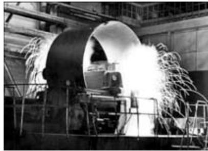
Контактная стыковая сварка обечаек на машине К767
