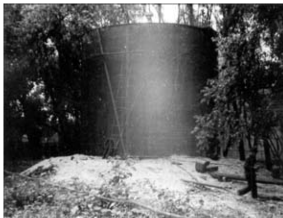
Рис. 1. Первый сварной резервуар вместимостью 240 \text{ м}^3 , сооруженный способом рулонирования на нефтебазе Укрнефтеснаб в 1948 г. в г. Киеве
