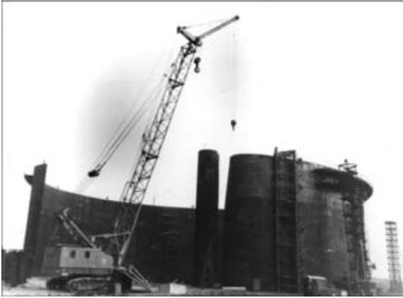
Рис. 3. Сооружение резервуара вместимостью 50 тыс. м<sup>3</sup> из сварных рулонных заготовок (1974 г.)
