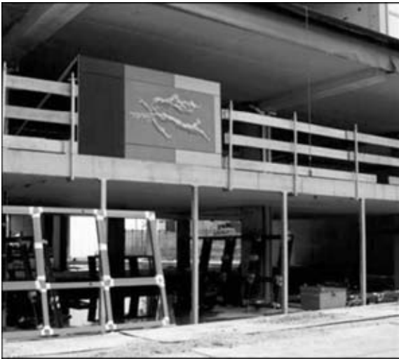
Рис. 8. Макет прототипа установлен на конструкции
