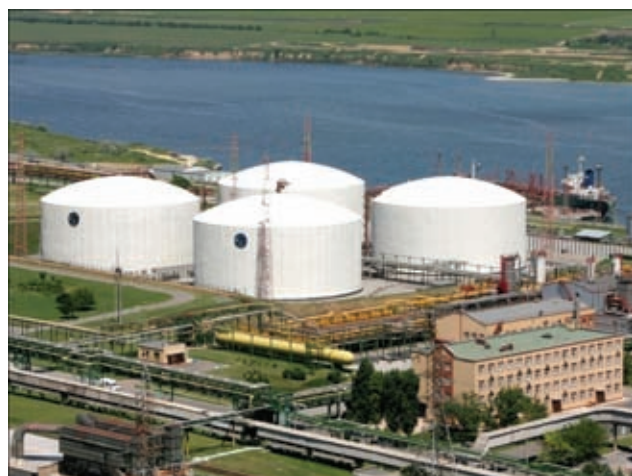
Рис. 1. Общий вид хранилищ аммиака ОПЗ
