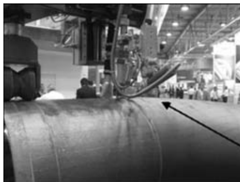
Рис. 8. Рабочий орган следящей системы, смонтированный на сварочной головке
