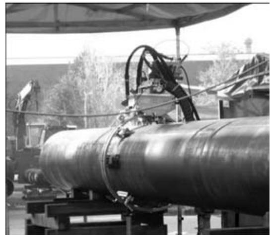
Рис. 8. Сварка труб с помощью установки опытной конструкции
