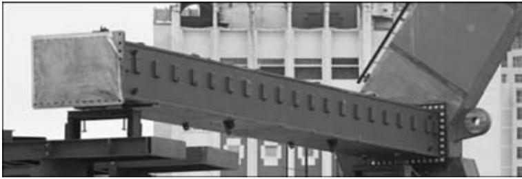
Рис. 2. Элемент сжатого пояса на монтаже
