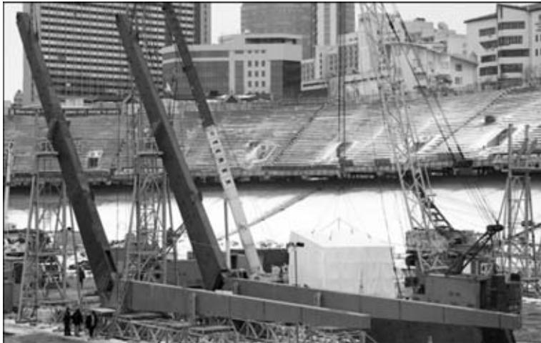
Рис. 3. Внешний вид готовых для монтажа колонн
