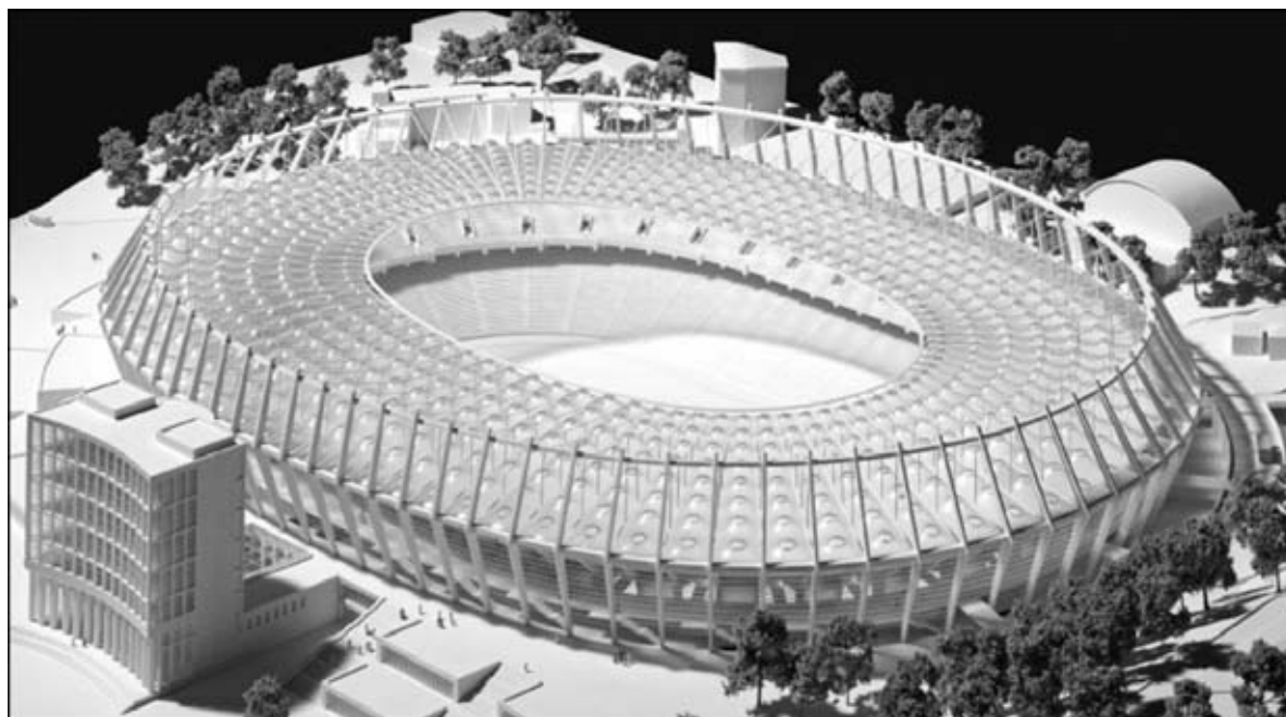
Рис. 1. Проектная конструкция навеса над НСК «Олимпийский» в Киеве
