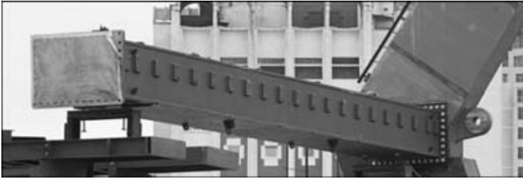
Рис. 2. Элемент сжатого пояса на монтаже
