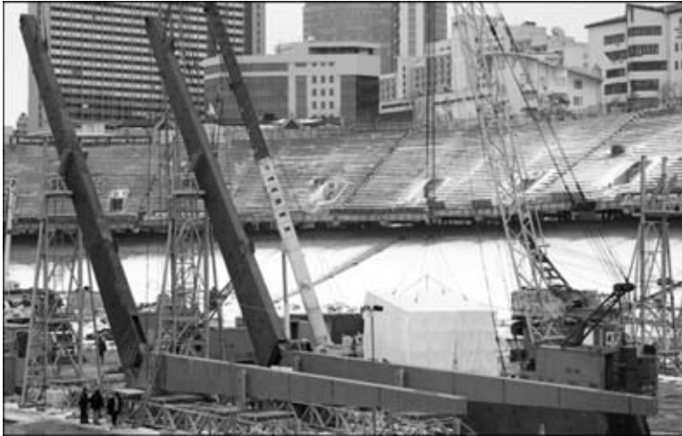
Рис. 3. Внешний вид готовых для монтажа колонн
