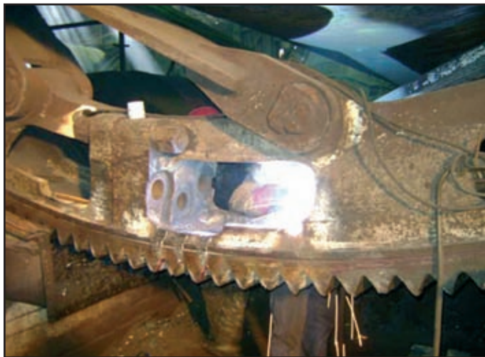
Восстановленный зубчатый венец обжиговой печи
