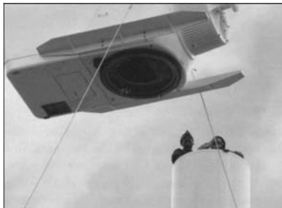
Рис. 3. Монтаж гондолы ветрогенератора большой мощности на башне ветрогенератора
