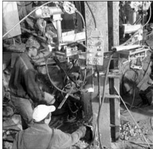
Рис. 4. ЭШС плавящимся мундштуком элементов усиления проемов поясов строительных колонн с использованием аппаратов АШП 113 М2
