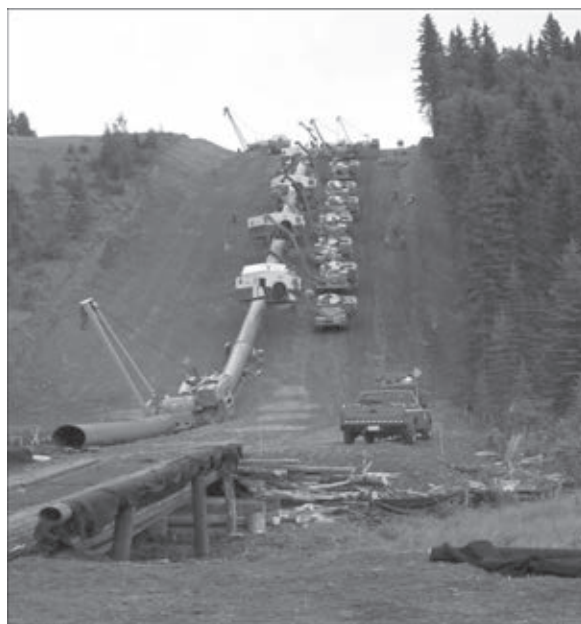
Рис. 4. CRC колонна на трассе
