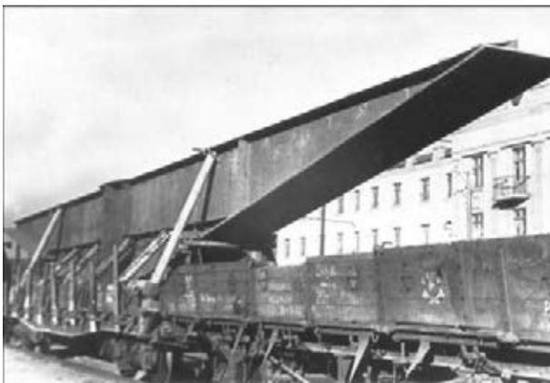
Рис. 12. Вут, погруженный на платформу
