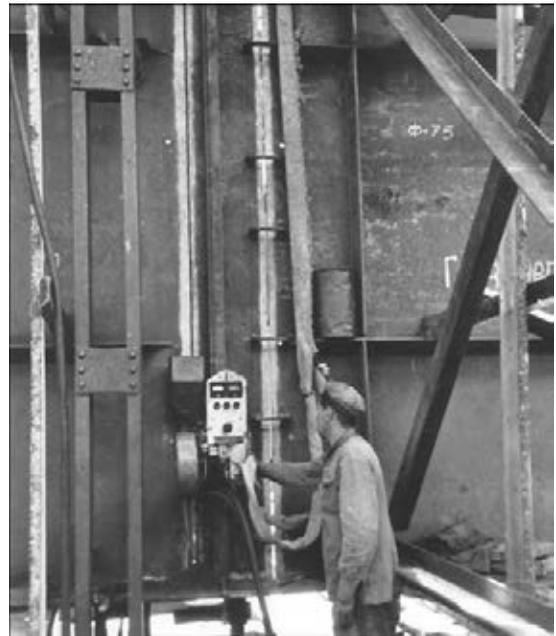
Рис. 13. Сварка вертикального монтажного стыка автоматом А-314
