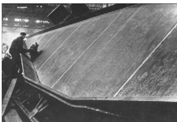
Рис. 9. Сварка поясных швов вута в кондукторе
