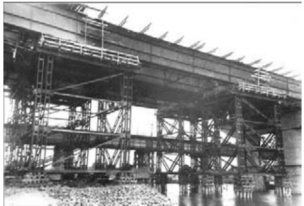
Рис. 14. Общий вид сварного монтажного стыка в пролете
