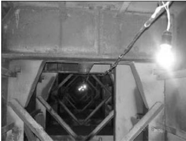
Рис. 1. Ребра жесткости внутренних отсеков перегружателя вблизи диафрагмы формирует конструктивный концентратор напряжений [2].
