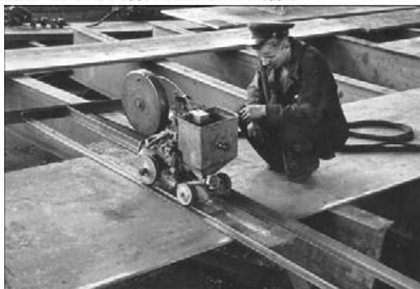
Рис. 5. Сварка трактором ТС-17-М стыкового шва стенки
