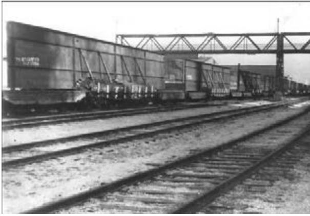
Рис. 11. Эшелон с главными балками на заводских путях
