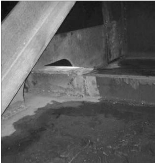
Рис. 6. Сварной узел измененной конструкции
