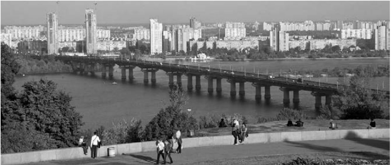
Рис. 1. Цельносварной мост им. Е. О. Патона через р. Днепр в Киеве
