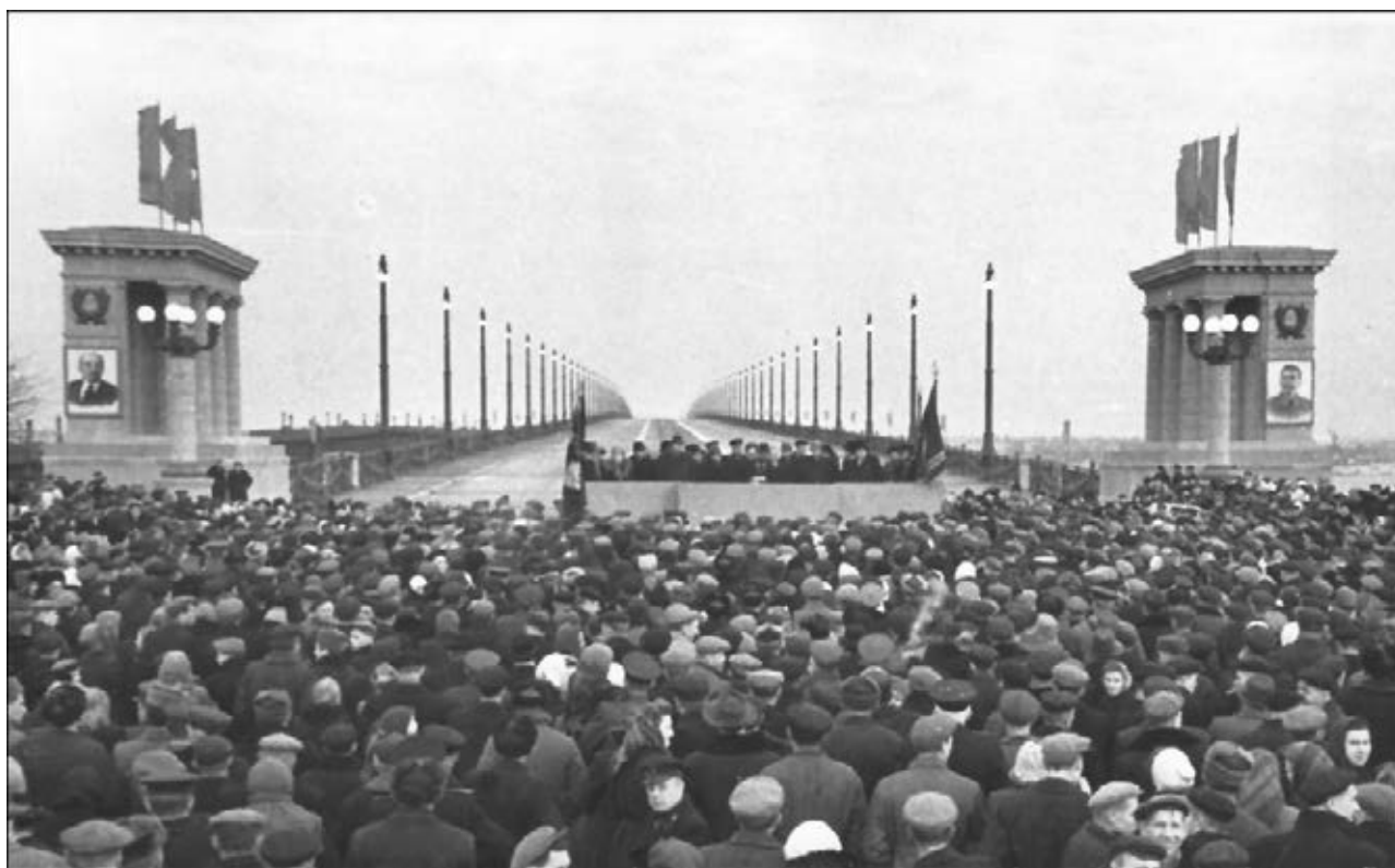
Рис. 16. Торжественное открытие моста 5 ноября 1953 г.
