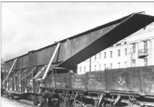
Рис. 12. Вут, погруженный на платформу
