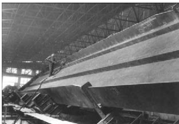
Рис. 7. Процесс сварки продольных стыков трактором ТС-17-М в кантователе
