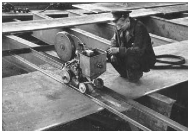
Рис. 5. Сварка трактором ТС-17-М стыкового шва стенки
