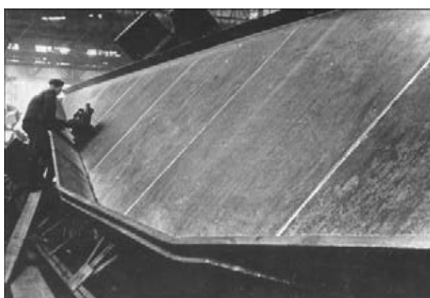
Рис. 9. Сварка поясных швов вута в кондукторе
