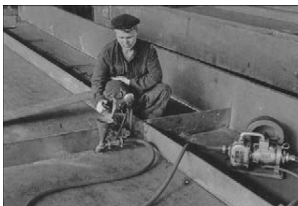
Рис. 6. Приварка ребра жесткости полуавтоматом ПШ-5 с держателем ДШ-27
