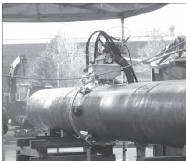
Рис. 3. Сварка труб с помощью установки для испытаний
