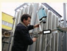
Размещение портативной Ф/Р аппаратуры на четырехточечном трубопроводе
