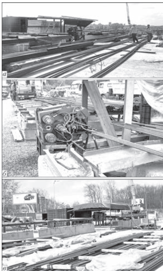
Рис. 7. Макеты линий для сварки арматуры на строительной площадке Подольского мостового перехода через р. Днепр (а), ригелей VIP-сектора НСК «Олимпийский» (б) и подъездной эстакады терминала D аэропорта «Борисполь» (в)
