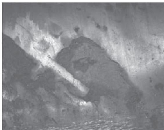
Рис. 1. Вид поврежденный металл облицовки КРК из стали СтЗсп
