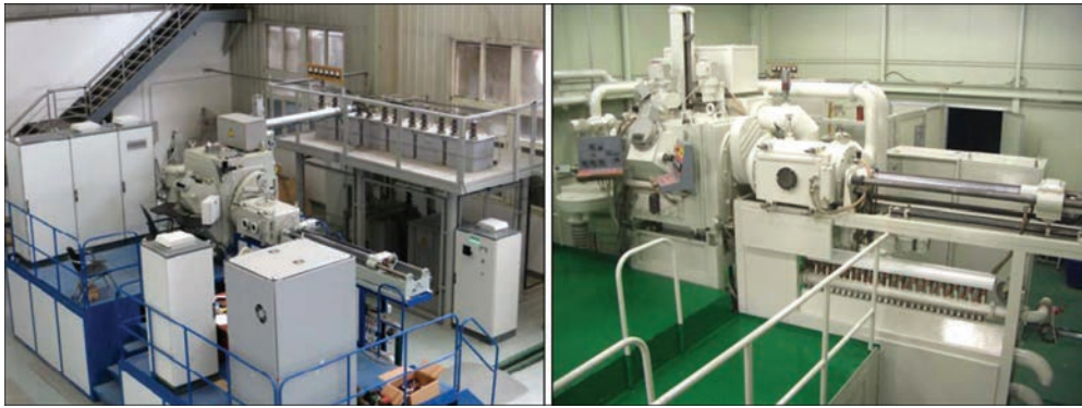
Рис. 1. Общий вид установки L-2
