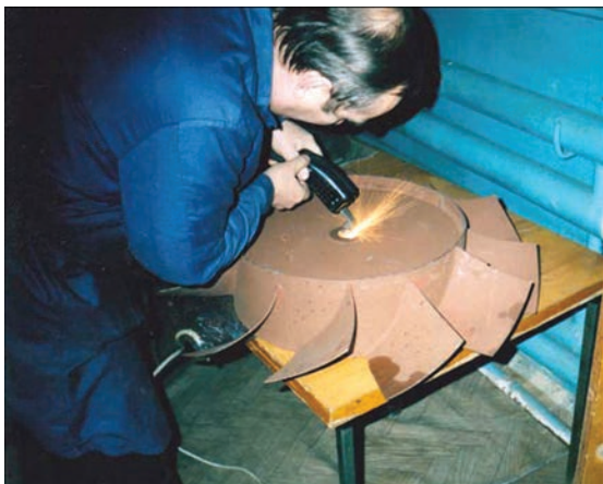
Рис. 7. Восстановление посадочных мест промышленных вентиляторов
