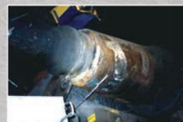
Восстановленный участок после сварки
