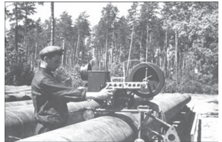
ТС-17 на трассе газопровода Дашава–Киев–Москва, 1950 г.
