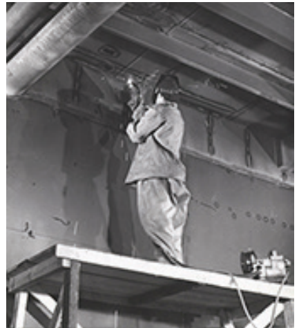
Сварка в углекислом газе, Николаев, 1950 г.
