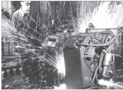
Испытания аппарата контактной стыковой сварки рельсов, 1960 г.
