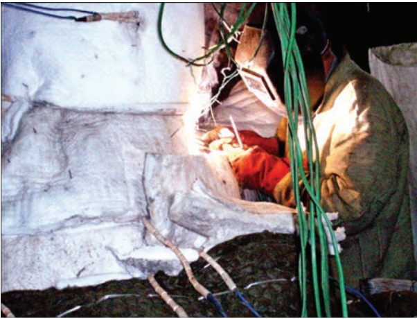
Рис. 7. Выполнение ремонтной сварки трещины в корпусе регулирующего клапана ЦВД
