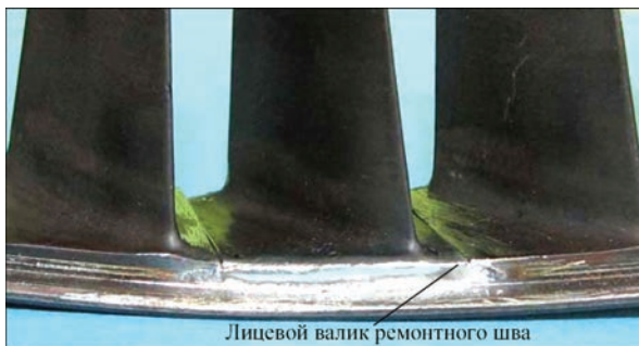
Рис. 13. Вид ремонтного соединения с торца полукольца направляющего аппарата
