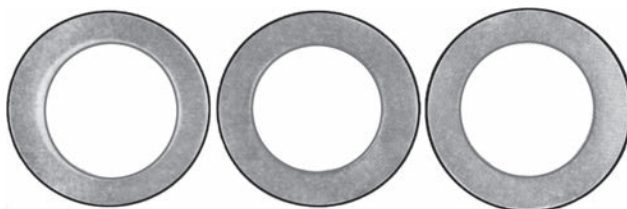
Рис. 3. Поперечное сечение упрочненных МТО труб НРЧ после 21 тыс. ч эксплуатации
