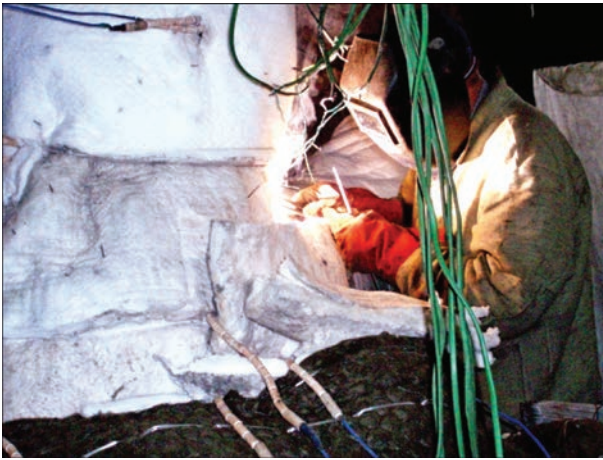
Рис. 7. Выполнение ремонтной сварки трещины в корпусе регулирующего клапана ЦСД
