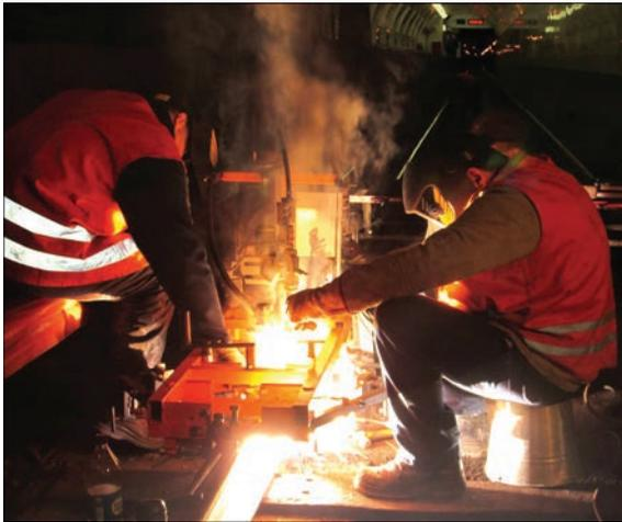
Рис. 2. Автоматическая электродуговая сварка рельсов ванным способом плавящимся мундштуком в туннеле киевского метрополитена
