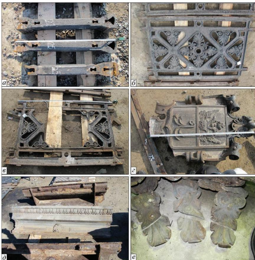
Рис. 4. Примеры состояния характерных деталей перильного ограждения: установленного при экспертном осмотре: *а* — столбы №№ 25, 26, 27; *б* — решетка №11; *в* — подгербовая решетка № 24; *г* — герб № 1; *д* — карниз № 8; *е* — угловые элементы декора № 1, 2, 3
