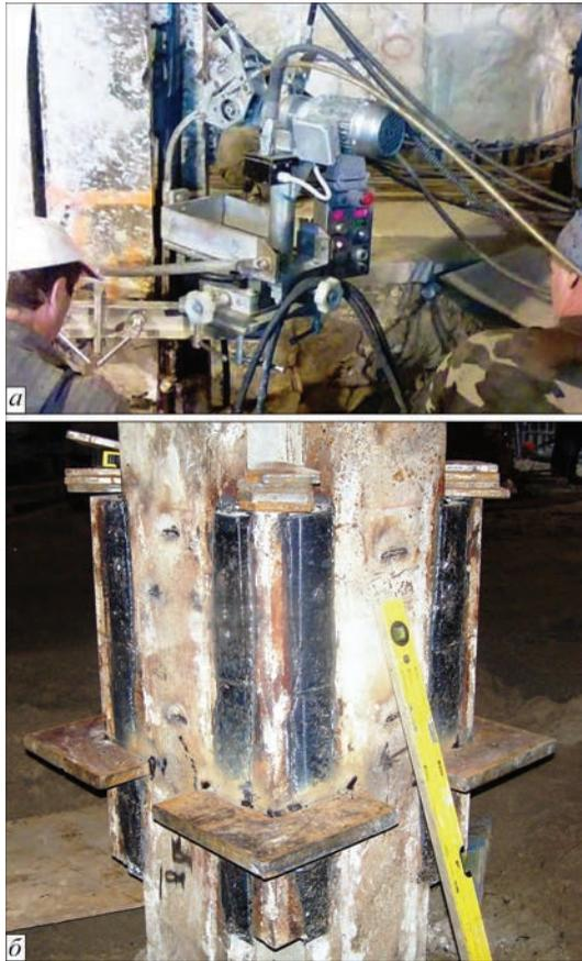
Рис. 7. Фрагмент электрошлаковой сварки плавящимся мундштуком усиленный проемов строительных колонн с использованием аппаратов АШП 113М2 (а) и внешний вид сварных швов (б)
