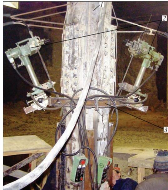
Рис. 4. Крепление аппаратов А-1304 на строительной колонне: 1 — колонна; 2 — сварочные аппараты; 3 — быстросъемная рама
