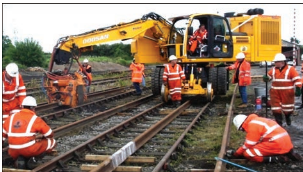
Рис. 22. Мобильный рельсосварочный комплекс (Великобритания)
