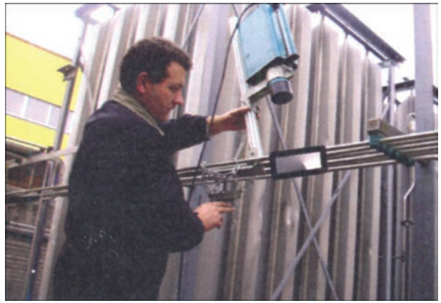
Рис. 20. Портативне цифрове рентгенотелевізійне обладнання, що розміщено на об'єкті
