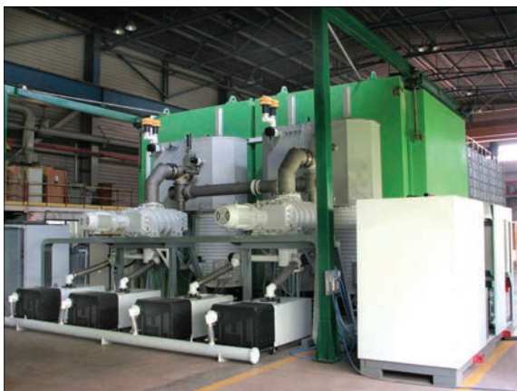
Рис. 3. Электронно-лучевая установка с вакуумной камерой объемом 100 м 3
