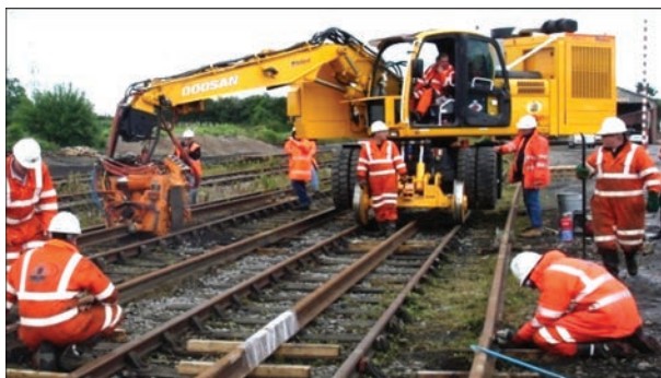
Рис. 22. Мобильный рельсосварочный комплекс (Великобритания)
