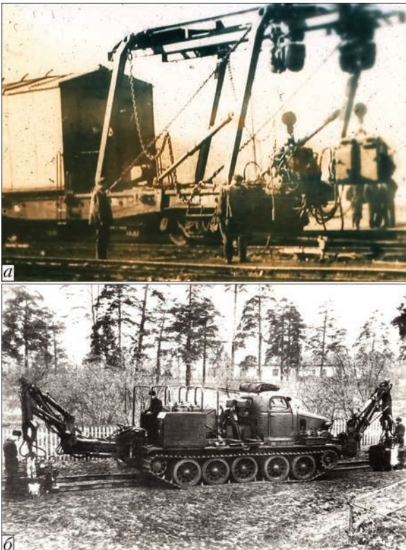
Рис. 1. Передвижные рельсосварочные комплексы с машиной К355: а — ПРСМ; б — РСА
