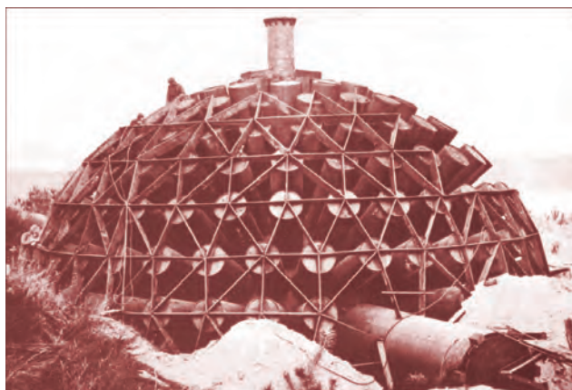
Трубочата камера потужністю 200 кг тротилу
