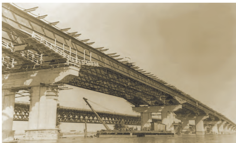
Прогонові будови мосту в період будівництва
