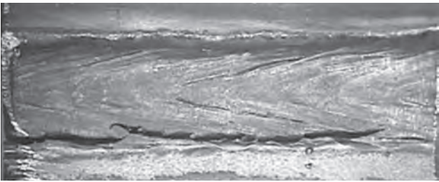
Рис. 4. Типичная геометрия продольной трещины на поверхности стыкового соединения нержавеющей стали SS2333 ( \delta = 10 мм), выполненного лазерно-дуговой сваркой с электродной проволокой Avesta 253MA (диаметром 1,2 мм) [9]
