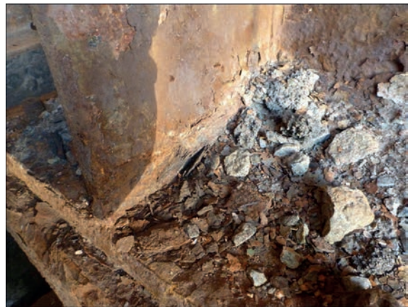
Рис. 10. Ділянка скупчення сміття в опорній частині чотирьохпрогонової споруди
