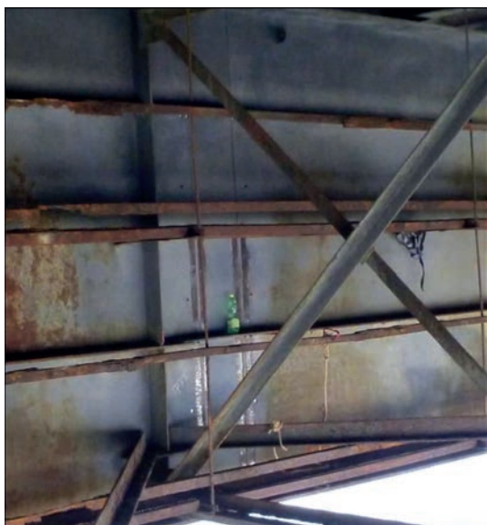
Рис. 5. Приклад контролю стикових вертикальних швів з'єднувальної вставки
