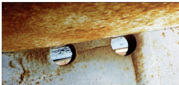
Рис. 7. Приклад відсутності росту дефекту, залишеного під час монтажу (кінці тріщини були зупинені методом свердлування) [4]
