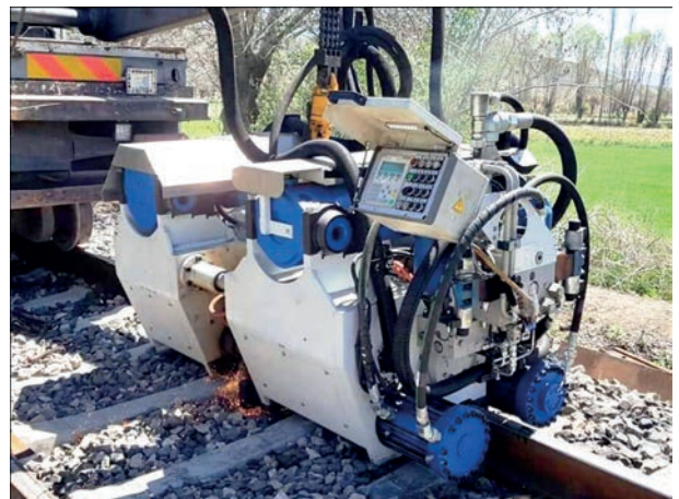
Рис. 6. Зварювальна головка AMS100
