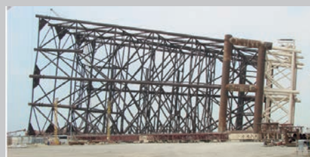
Базова платформа МСП-7 з зварними понтонами
