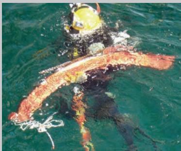
Перенесення заряду водолазом до місця встановлення
