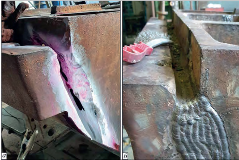
Рис. 5. Загальний вигляд ремонту тріщини № 2 на передній стінці після механічної обробки кромки (а) та після зварювання (б)
