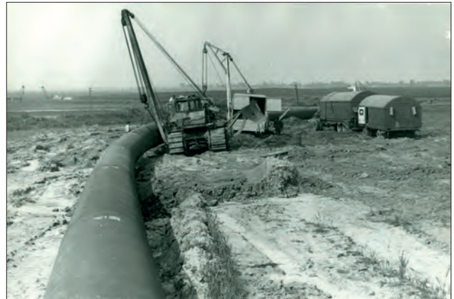
Рис. 10. Застосування технології ЕТЗ трубних батогів в горизонтальній площині
