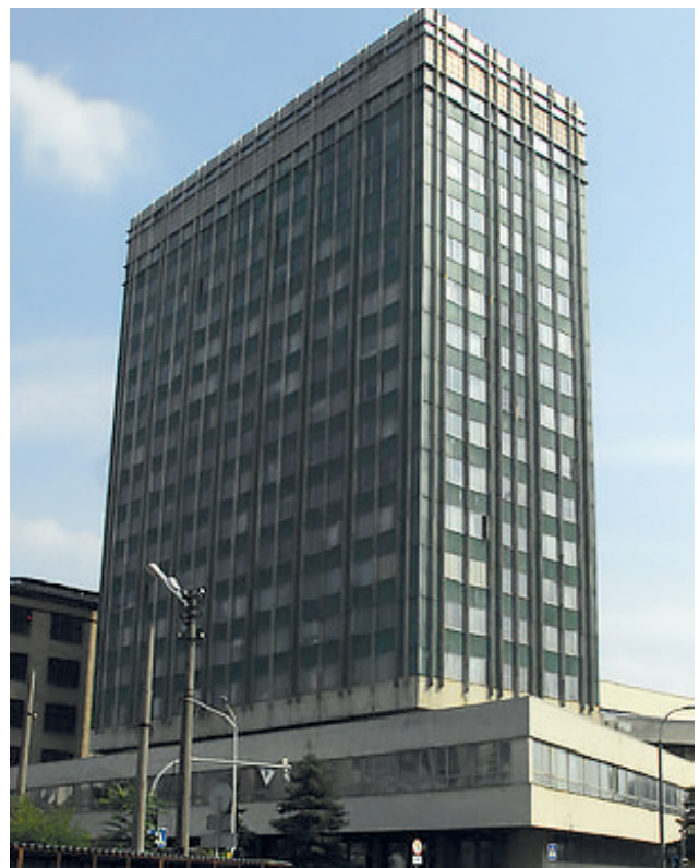
Головний корпус Інституту електрозварювання ім. Є.О. Патона
