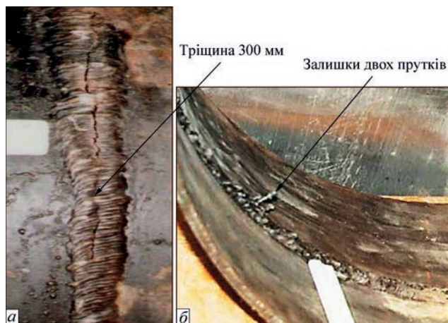
Рис. 5. Кільцеве з'єднання нафтопроводу діаметром 720 мм з тріщиною у шві: а – зі сторони зовнішньої поверхні труби; б – з внутрішньої поверхні труби
