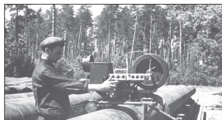
Зварювання трактором ТС-17 стиків газопроводу Дашава-Москва
