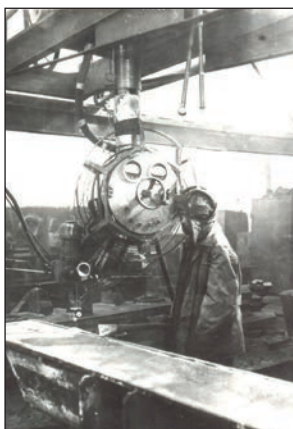
Пост зварювання корпусу
