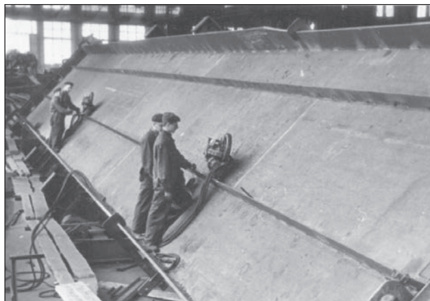
Зварювання мостової балки
