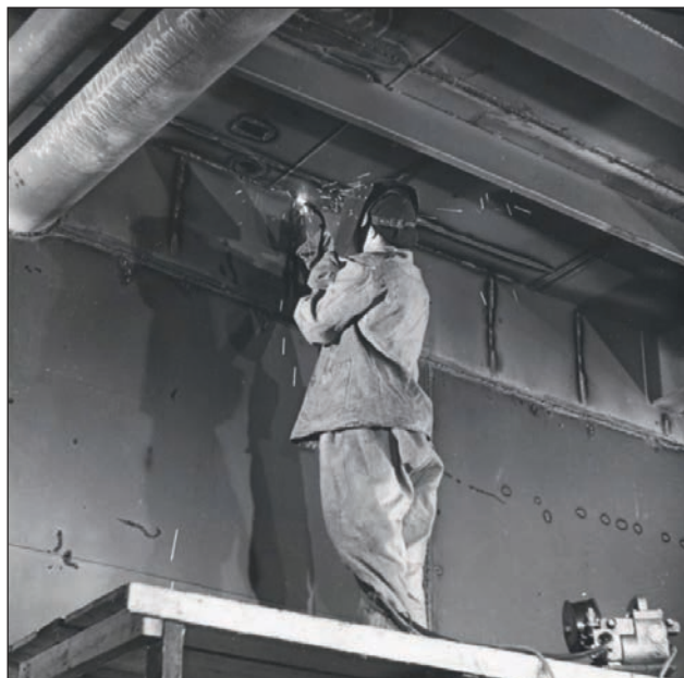
Приварка підпалубної секції
