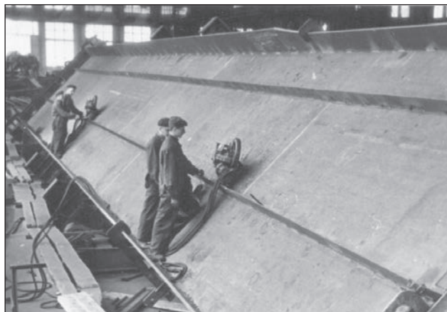
Зварювання мостової балки
