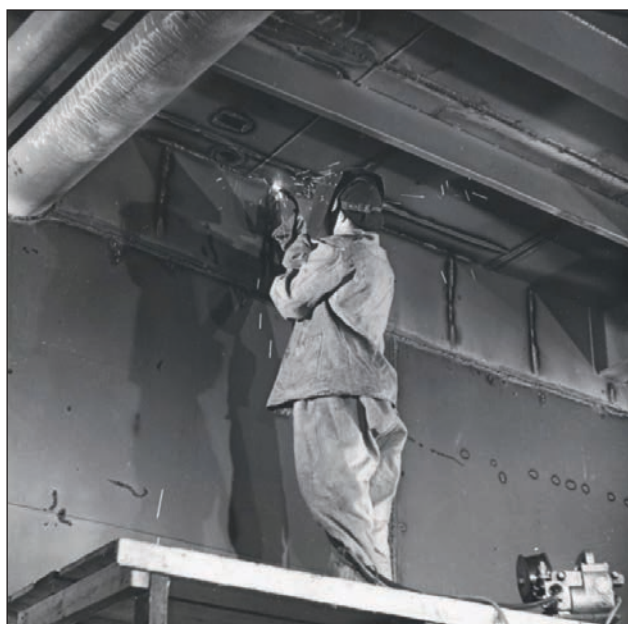
Приварка підпалубної секції
