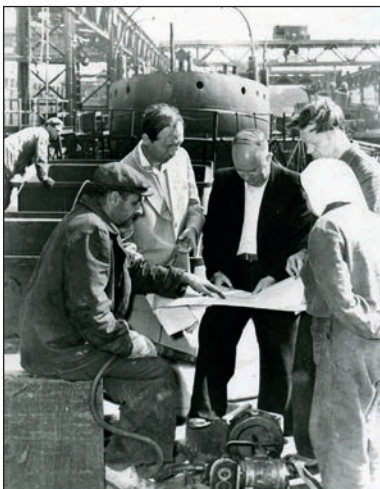
Впровадження шлангового напівавтомата для зварювання під флюсом (завод «Ленінська кузня», м. Київ, 1956 р.)
