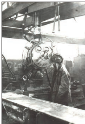
Пост зварювання корпусу
