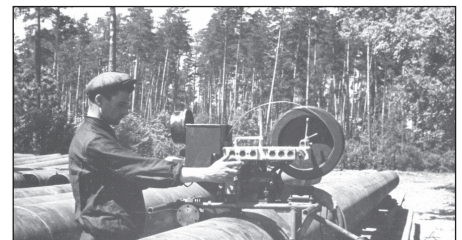
Зварювання трактором ТС-17 стиків газопроводу Дашава-Москва
