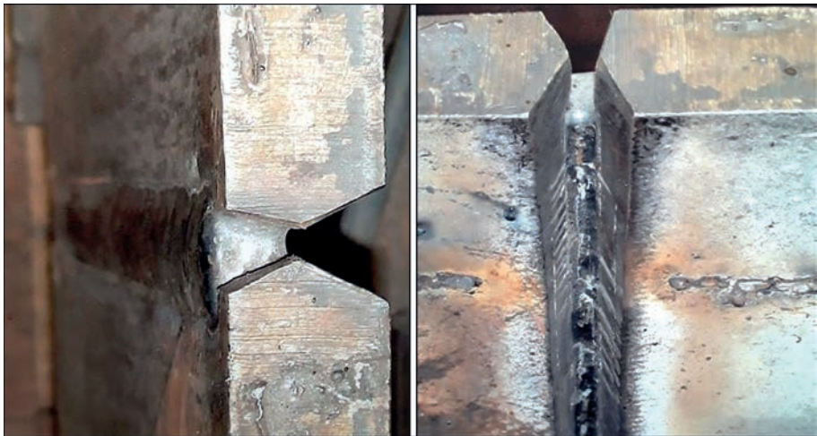
Рис. 8. Зовнішній вигляд зварного шва після виконання першого проходу на металі заготовшки 40 мм
