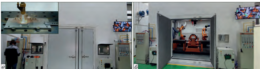
Рис. 10. Роботизована ділянка детонаційного газового напильнення з реалізацією ефекту акумулювання енергії в БКДП, з 6-осьовим роботом з максимальною довжиною переміщення руки 2238 мм і двоосьовим маніпулятором для обертання напильованих деталей
