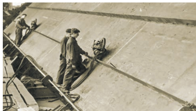
Зварювання балки мостового перекриття, м. Дніпропетровськ, 1952 р.
