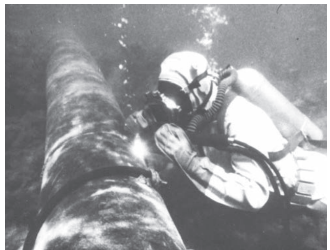
Процес зварювання порошковим дротом під водою
