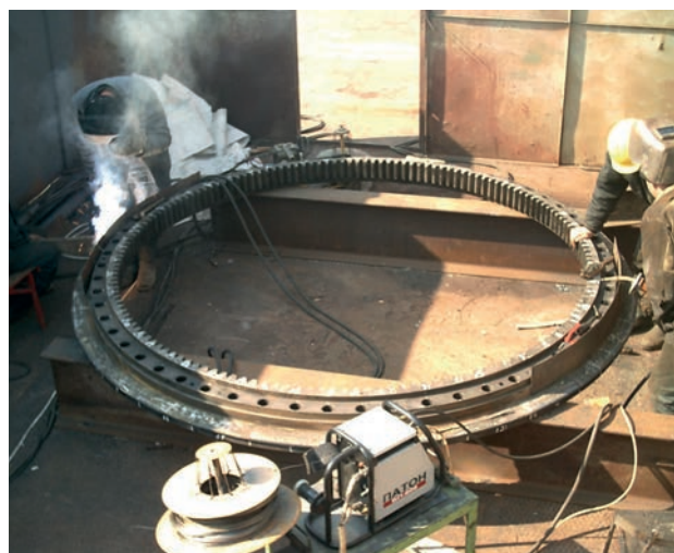
Напівавтоматичне наплавлення шестерні опорно-поворотного пристрою екскаватора
