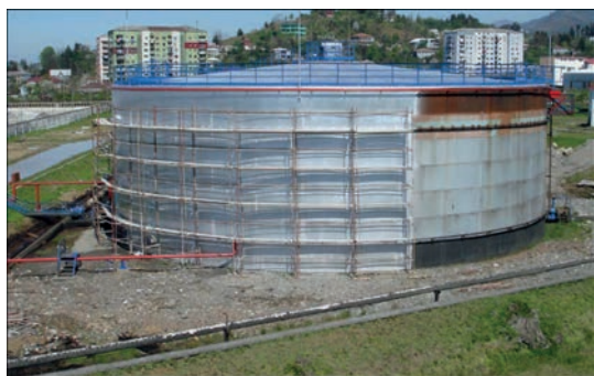
Рис. 19. Вигляд резервуара після ремонту в процесі нанесення протикорозійного покриття
