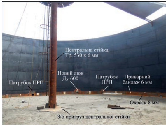
Рис. 10. Процес ремонту клепаного резервуара РВС-5000, вигляд із середини
