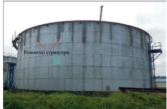
Рис. 12. Ремонтні стрингери, що встановлені в місцях приходу до стінки радіальних балок
