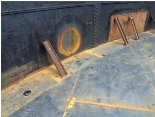
Рис. 16. Монтаж нового днища: окрайка завтовшки 8 мм, центральна частина – завтовшки 6 мм
