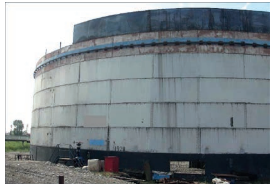
Рис. 17. Заміна верхнього поясу стінки з установкою фіксуючого кільця жорсткості
