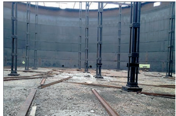
Рис. 13. Демонтаж існуючого днища та покриття резервуара
