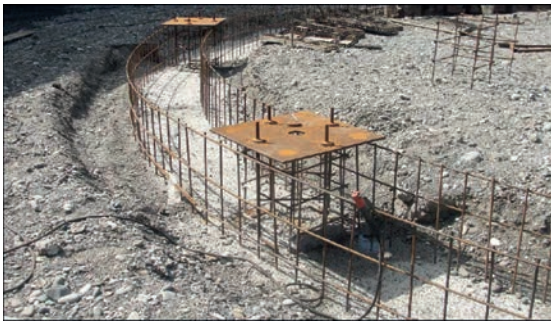
Рис. 15. Влаштування кільцевого залізобетонного фундаменту для опорних колон покриття
