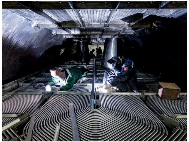
Зварювальні технології ІЕЗ ім. Є.О. Патона при виготовленні обладнання для атомних електростанцій
