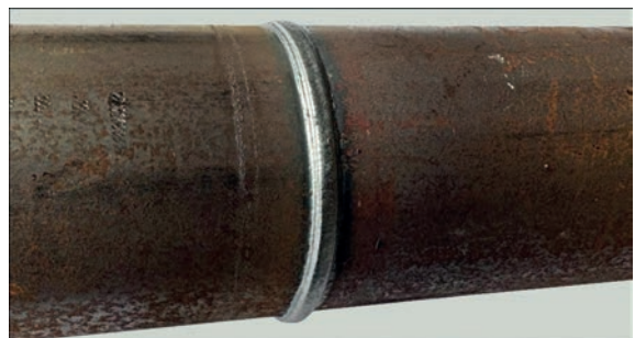
Рис. 9. Технологічно зменшена висота підсилення зварного шва на трубі
