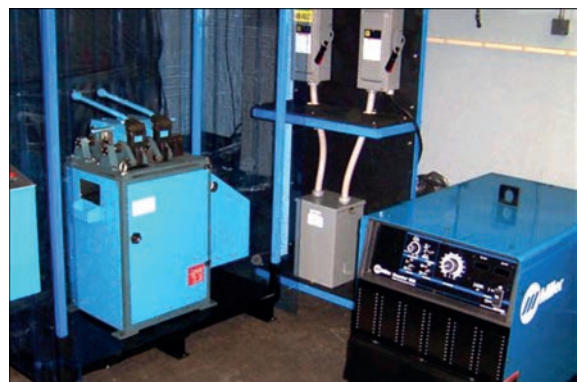
Рис. 6. Зварювальна установка МД101
