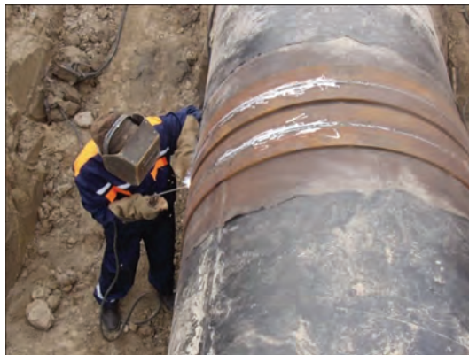
Рис. 6.4. Приклад технологічного збирання підсилювальної конструкції на дефектній ділянці трубопроводу без зміни режимів транспортування продукту
