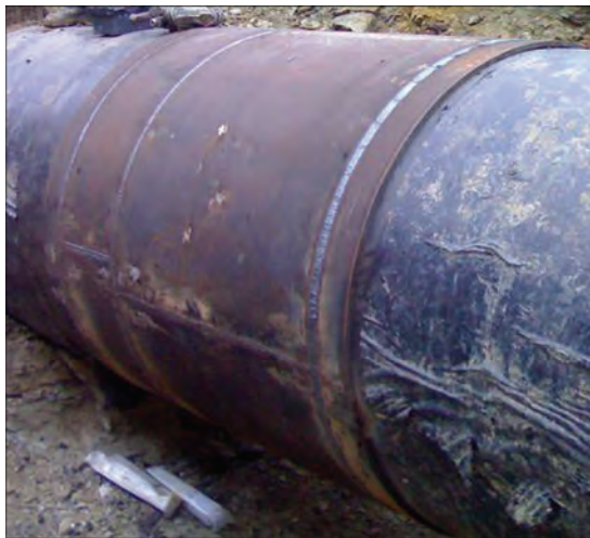
Рис. 6.7. Приклад реалізації підсилення дефектної ділянки магістрального газопроводу в умовах експлуатації
