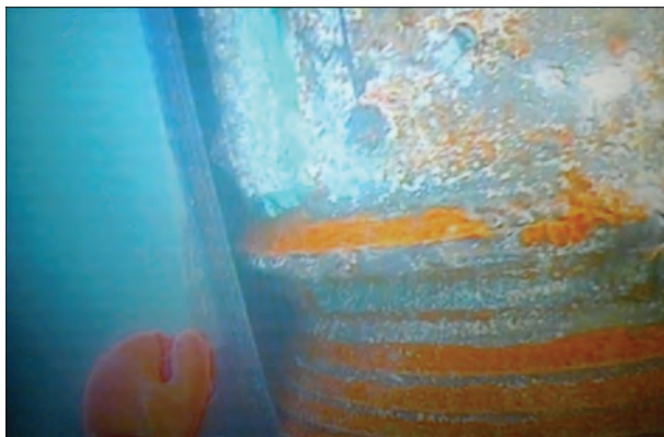
Рис. 5.21. Ремонтна конструкція перед встановленням другої половини бандажу
